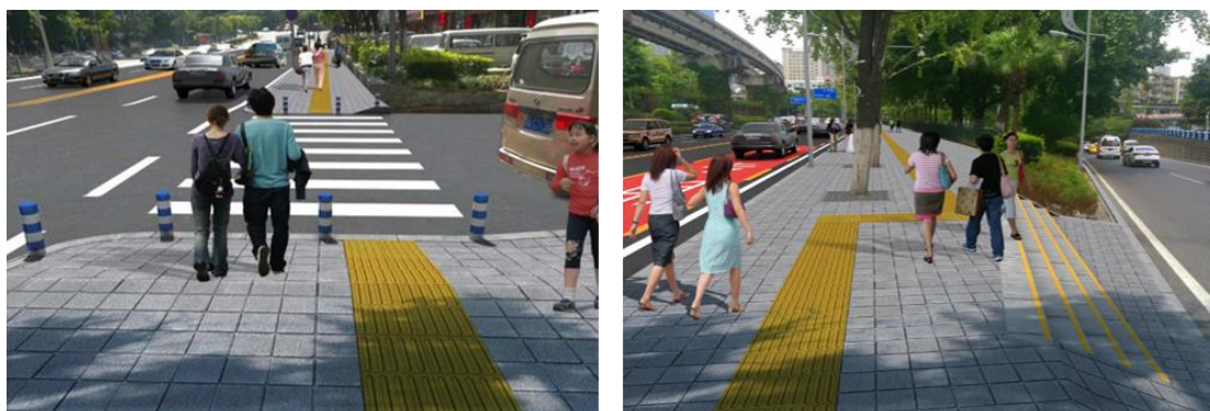
图 4.2.4 完整、连续的无障碍通道
