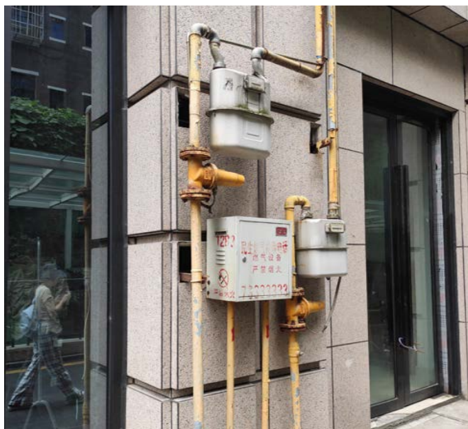
老旧小区管线规整后
