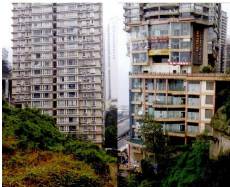
建筑吊层空间改造
