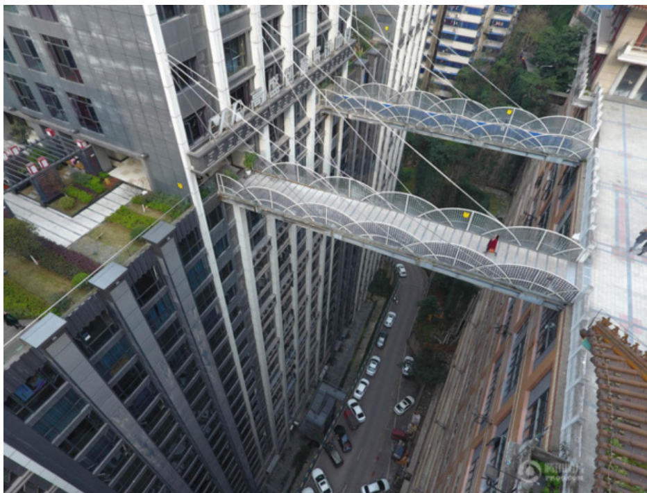
魁星楼广场步行天桥
