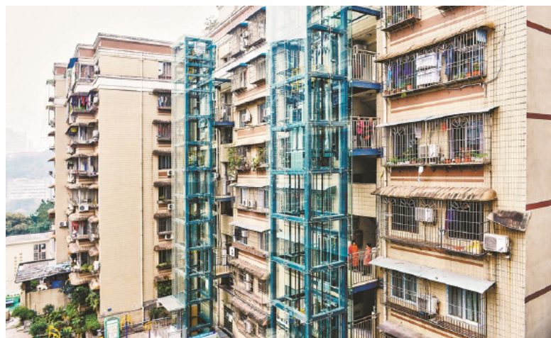
老旧小区加装电梯
