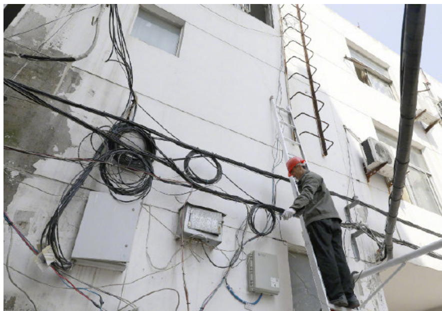
老旧小区管线规整过程中
