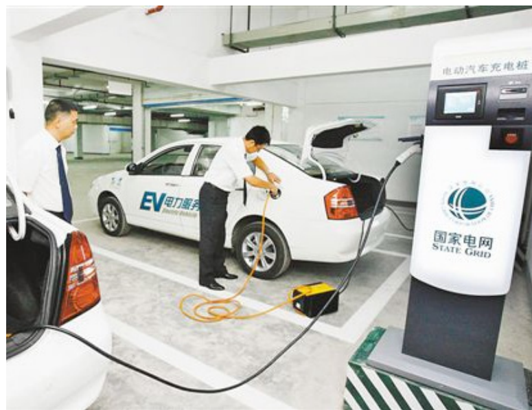
地下车库停车位及充电设施
