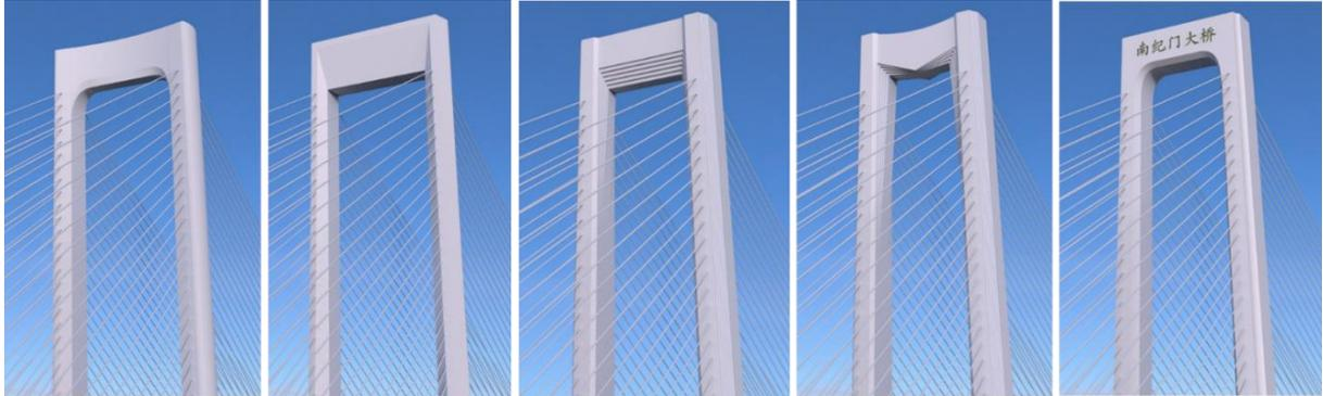
图 D.3.1-1 桥塔塔冠建筑造型比较
