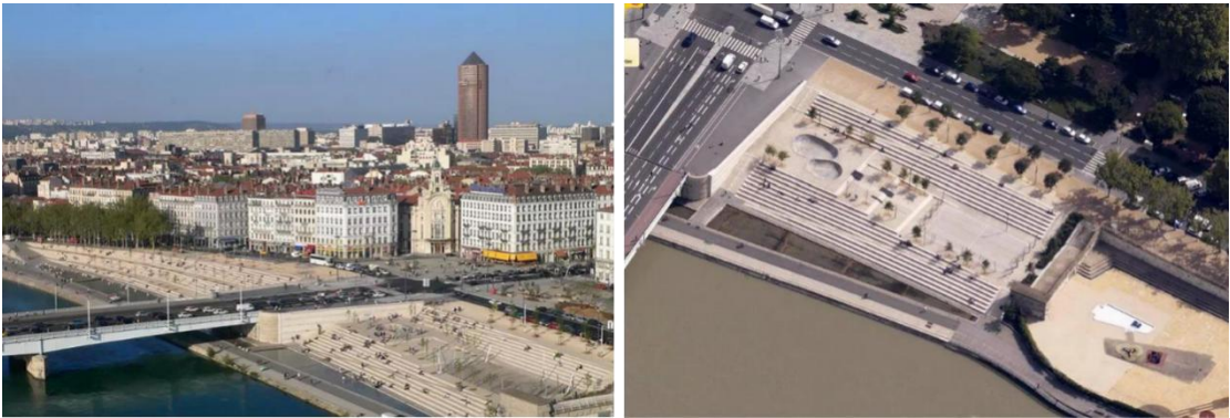
图 5.20-Guillotière 桥的桥头广场
