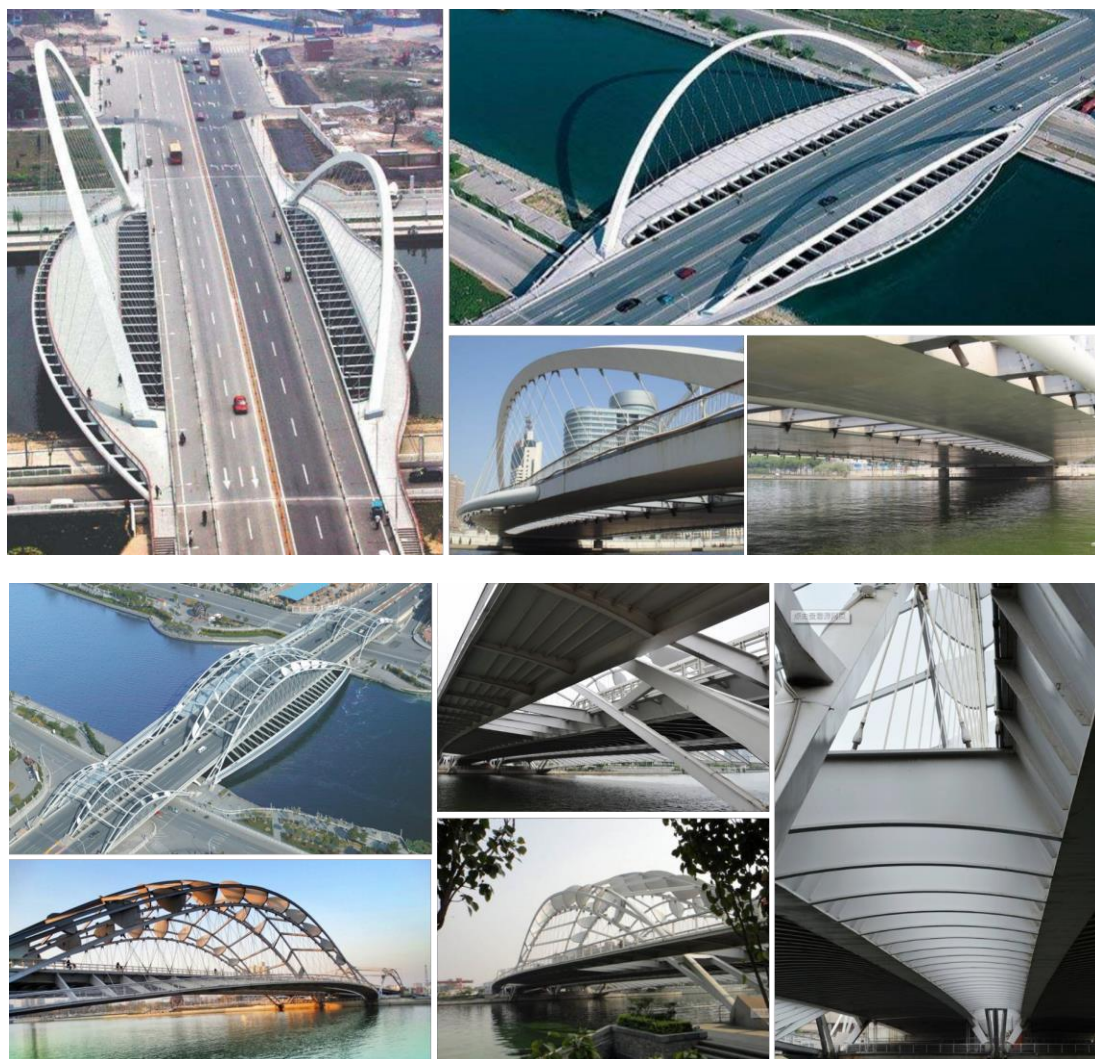
图 5.25-大沽桥和直沽桥桥下采光
