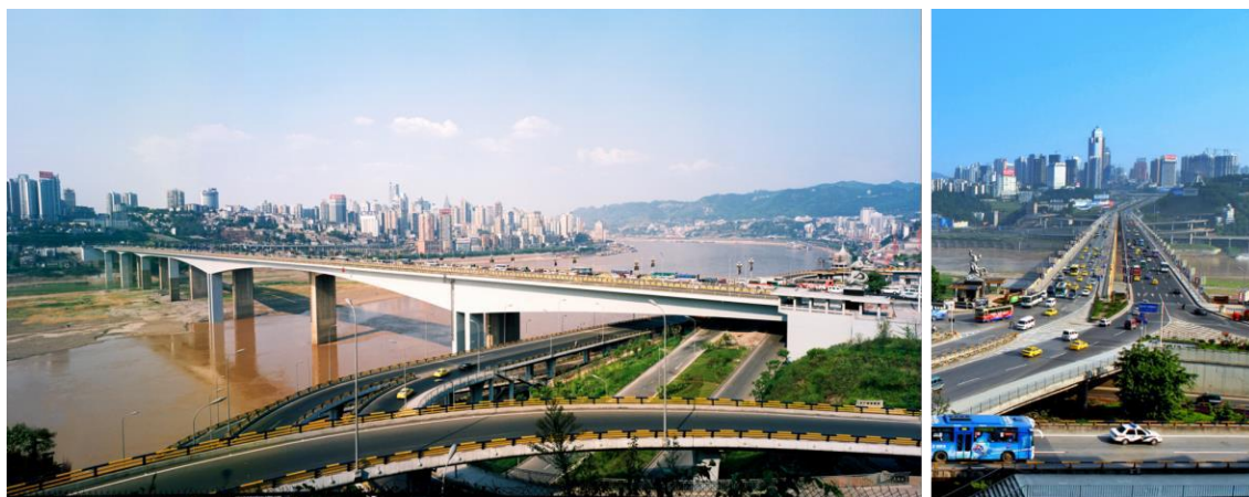
图 5.3-石板坡长江大桥与复线桥
