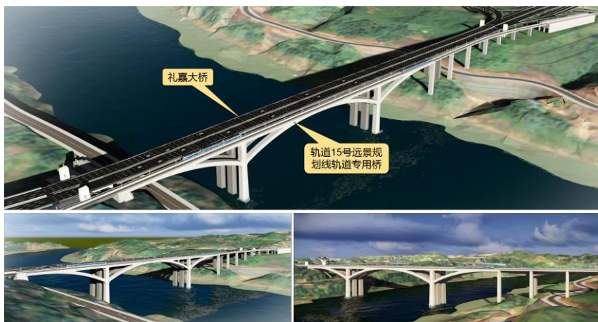
图 5.4-礼嘉嘉陵江大桥与轨道 15 号线跨嘉陵江大桥
